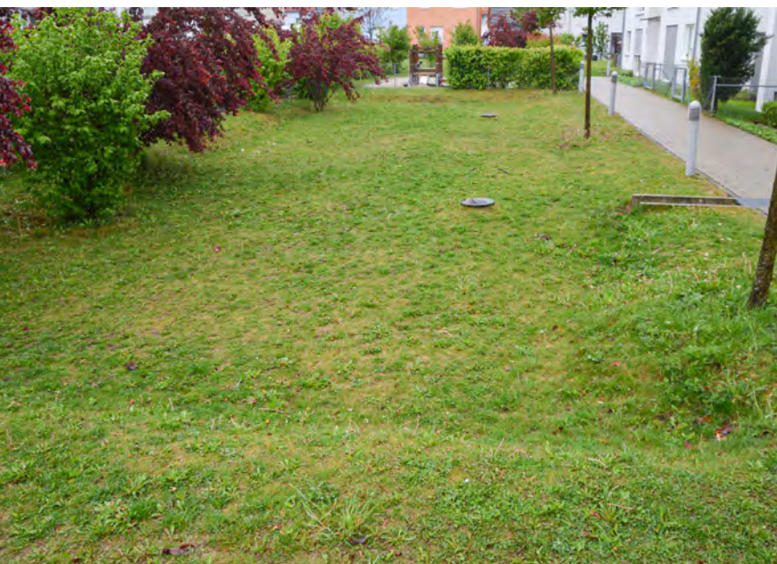
Abb. 44 Dezentrale Versickerungsfläche im Wohngebiet
