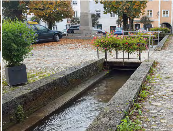
Abb. 37 Reaktivierung Dorfbach bei beengten Verhältnissen
