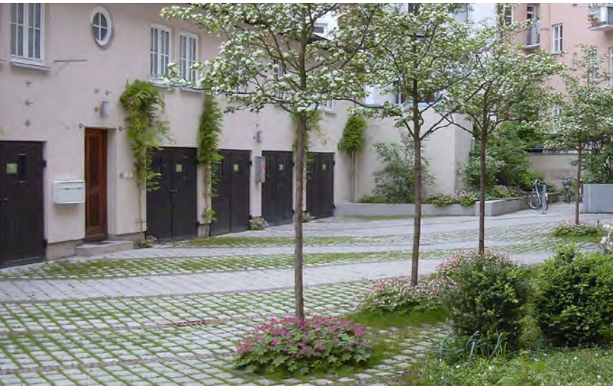
Abb. 15 Durchlässige Beläge in einem Innenhof
