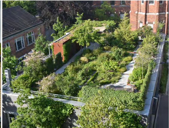
Abb. 19 Intensives Gründach auf einem Verwaltungsgebäude
