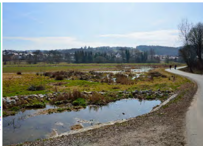
Abb. 54 Umleitung des gesammelten Niederschlagswassers
