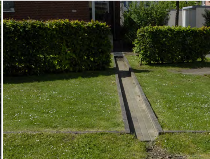
Abb. 27 Sammelrinne zur Ableitung auf Rasenfläche
