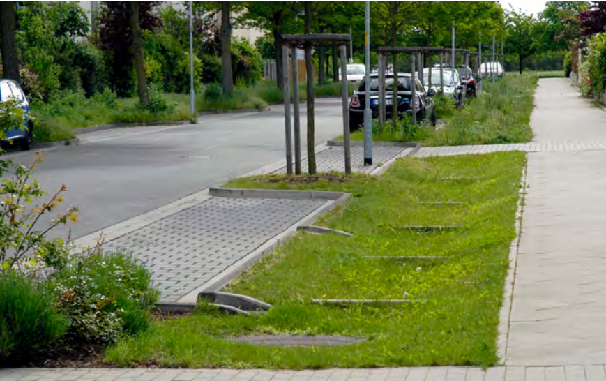
Abb. 22 Muldenkaskaden zur Versickerung von Straßenabflüssen
